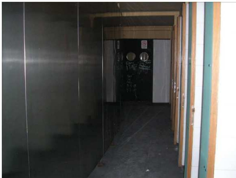
Bagni al piano interrato
